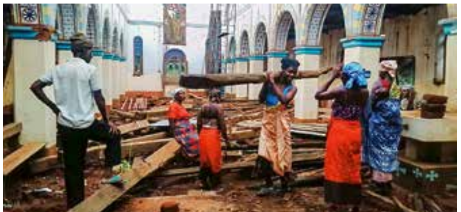
Reconstrucción de la iglesia parroquial de San José en Mitúcue.
